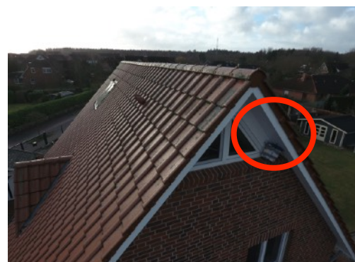
(Bild 4: Box mit Tablet am Dachstuhl zwecks Messung)
