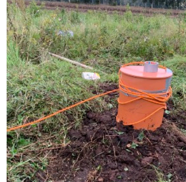
(Bild 14: Das KG-Rohr im Boden)
